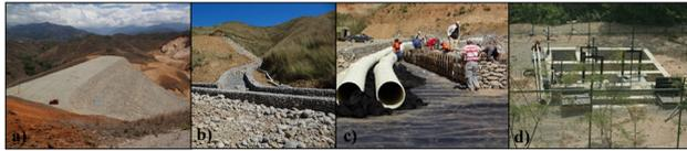
**Figura 1.** a) Vista panorámica de la presa (mayo 2014), b) Construcción del sub-dren principal y lateral, c) Estructura drenante para recoger agua con lixiviado. d) Caja hidráulica de distribución de agua con lixiviado y de escorrentía.
