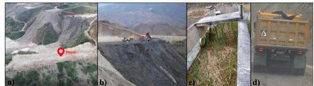
**Figura 5.** Año 2019, a) Vista panorámica del dique y 3 plataformas cuya cota superior supera ( $\pm 25m$ ) a la cota del dique. b) Trabajos de volteo de material conformando taludes susceptibles a movimientos en masa y erosión. c) Falta de mantenimiento de infraestructura drenante. d) La administración de la relavera no exige cubrir el balde de las volquetas con lona (derrame de relave en vías).
